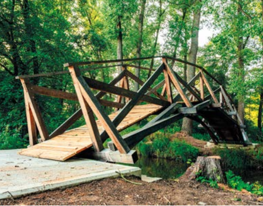
Lávka Mjr. Aubrechta
